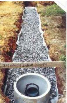
図 8-4 まず、透水管の据付
