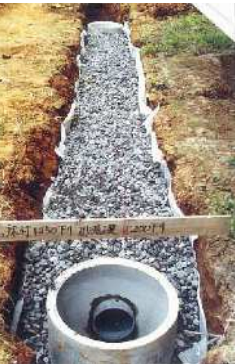
図 8-4 まず、透水管の据付
