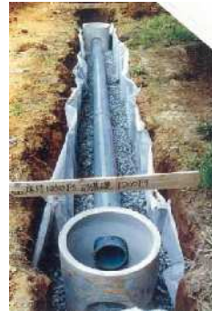
図 8-5 充填砕石工の完了
