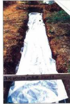
図 8-6 透水シート覆工後の状況
