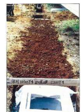
図 8-7 埋戻し状況
