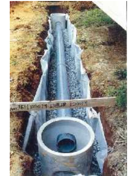
図 8-5 充填砕石工の完了
