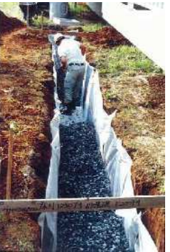
図 8-3 充填砕石の施工
