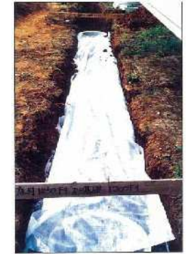
図 8-6 透水シート覆工後の状況
