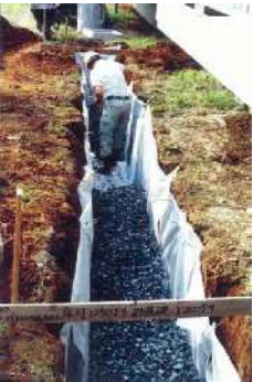
図 8-3 充填砕石の施工
