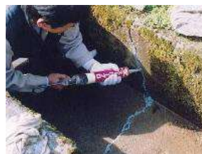
水路のひび割れ補修
