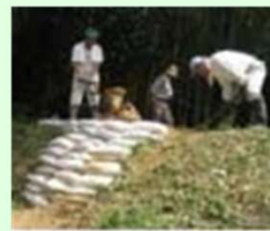
漏水箇所の補修
