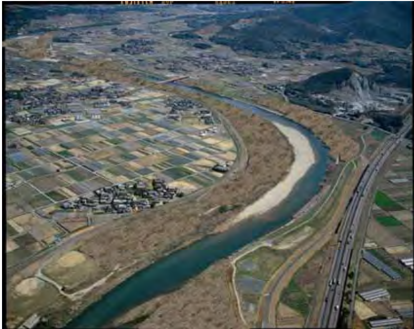
河道内樹木全伐採
