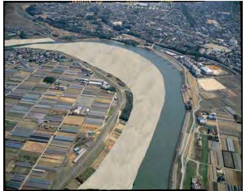
低水路全拡幅
