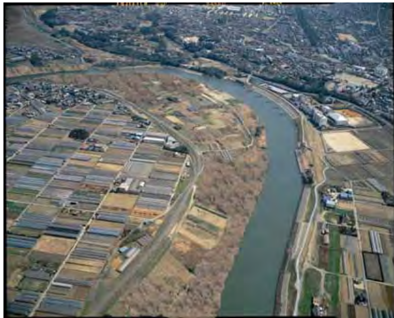
河道内樹木全伐採
