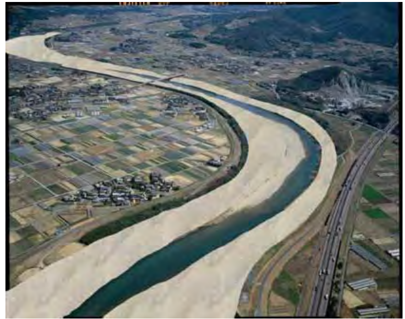
低水路全拡幅
