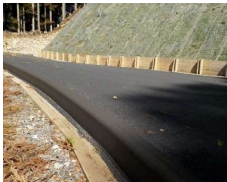
柵工、縁端処理工
