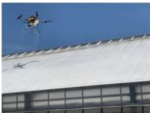
ドローンを用いた遮熱剤塗布
