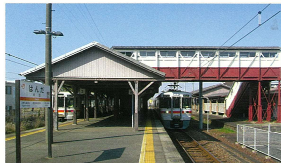
半田駅ホーム(高架工事着手前)
