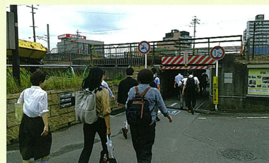
幅員狭小道路の現状 (幅員4.0m未満の道路)
