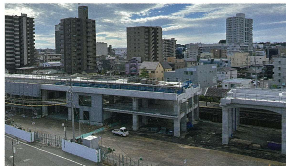
高架工事状況(2025年10月)
