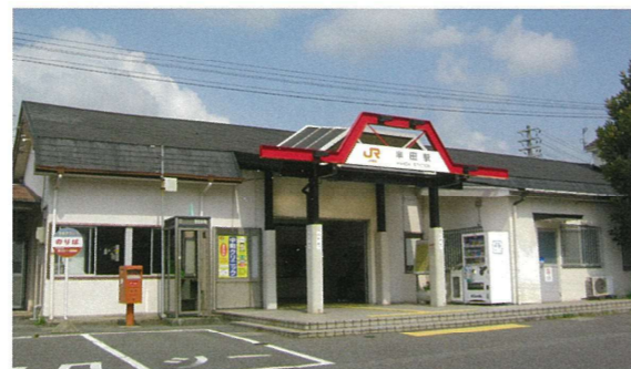
半田駅(高架工事着手前)
