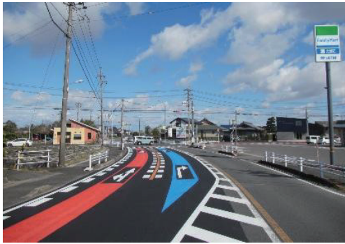
図表2-4-1-14 事故危険箇所のカラー舗装対策 (一) 一宮津島線 (大牧交差点)
