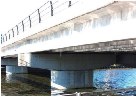
図表2-4-1-2 緊急輸送道路等の橋梁の耐震化（弥富市新宝川橋）
