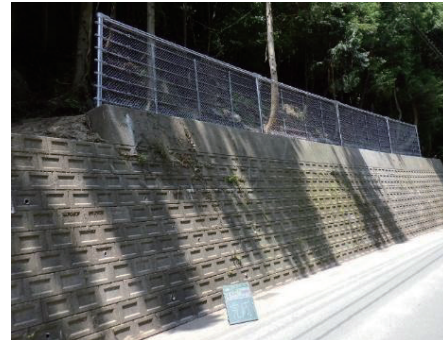
図表2-4-1-3 緊急輸送道路等の法面对策（(国)301号（新城市作手保永））
