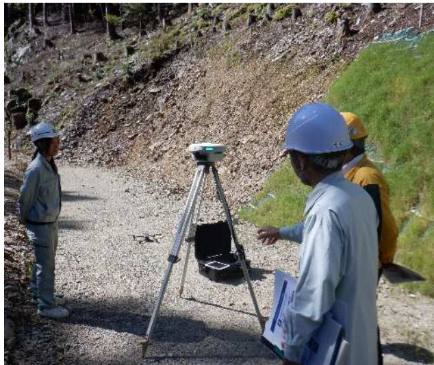
起工測量時の立会状況
