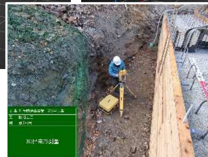
◀ 出来形計測状況
