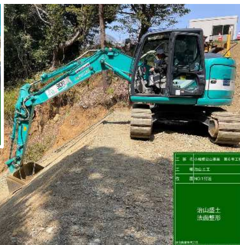
3次元MCバックホウによる施工状況
