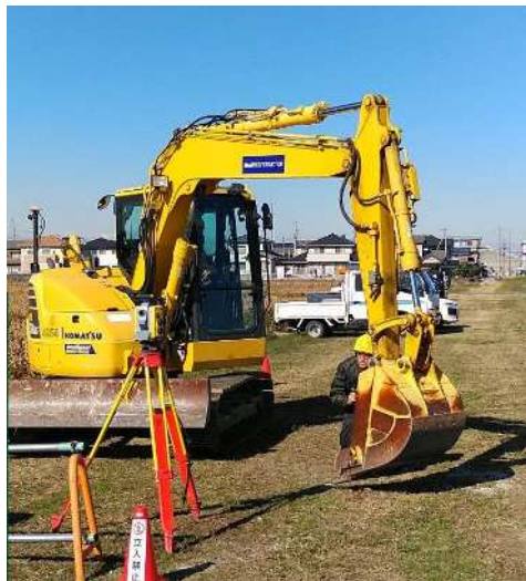
MCバックホウの刃先精度確認
