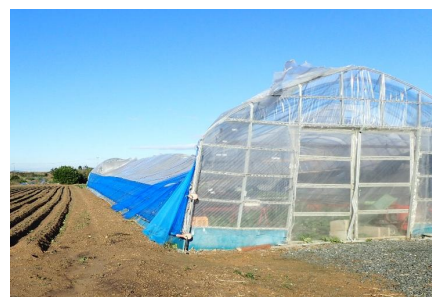
台風によるハウスの損壊
