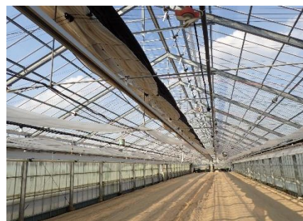
被覆資材交換・補修工事
