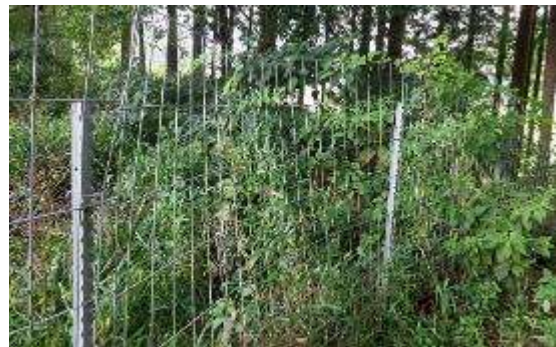
点検・補修した侵入防止柵
