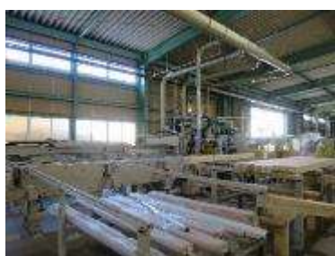
大森木材株式会社 プレカット加工施設
