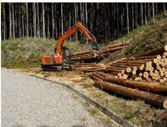
過疎山村地域代行林道事業（開設） 中口尤線 2 工区工事（設楽町）
