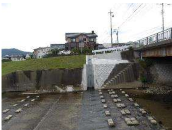
取水堰の整備（新城市野田地区）
