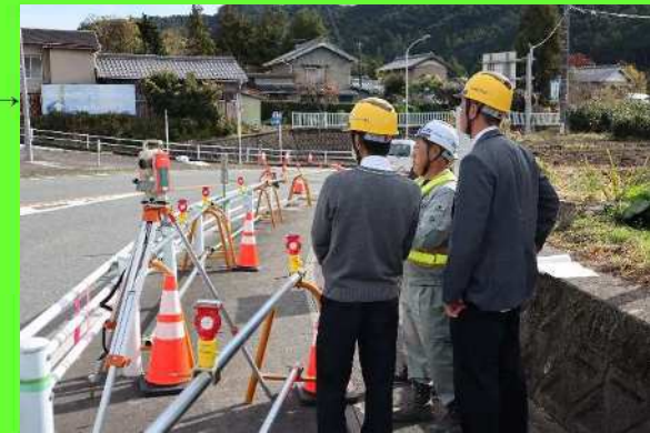
工事現場の視察 →
