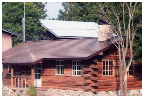
写真 3-5 丸太組構法 外部両面丸太現し（外部）
