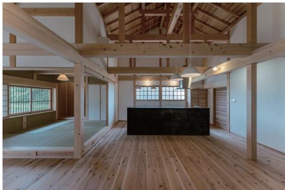
③季節により空間の大きさが調査可能なLDKと茶の間
