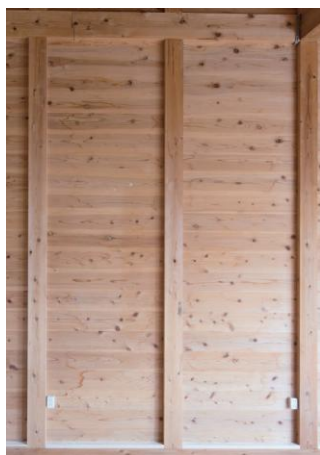
(a) 内側落とし込み板現し
