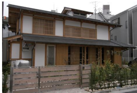
写真 3-3 土塗壁を用いない外壁両面真壁（外部）
