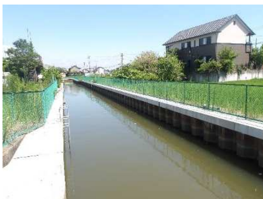
整備・更新した排水路（稲沢市）
