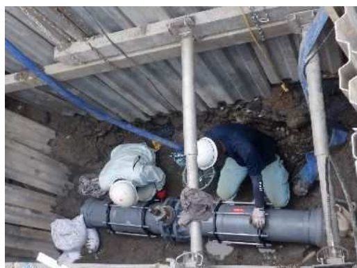
農業用水管の施工状況（小牧市）
