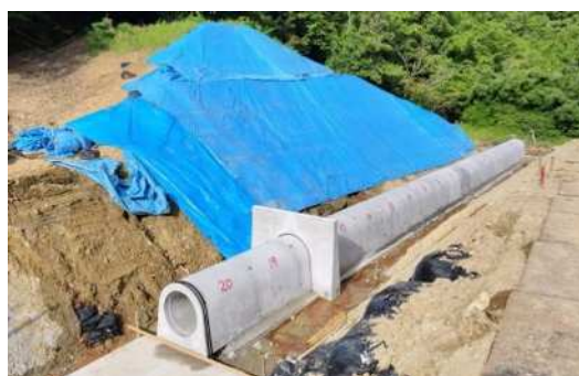
北洞南池底樋管設置状況（犬山市）
