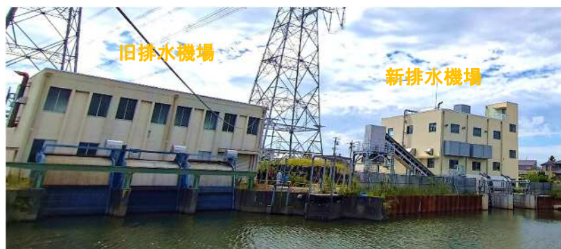
供用開始した(新)大久伝排水機場[右]と旧排水機場[左]（豊明市）
