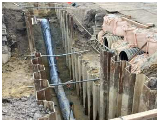
農業用水管の施工状況（日進市）
