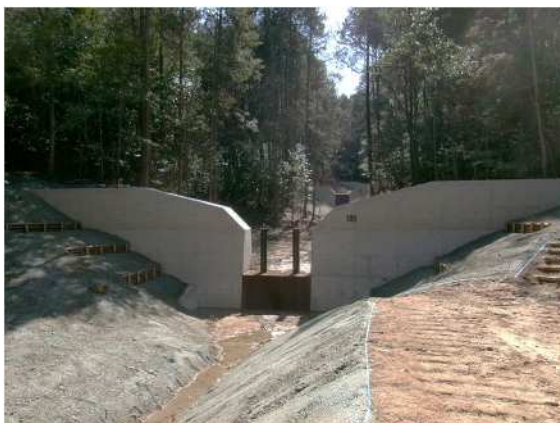
谷止工（鋼製スリットダム） （瀬戸市）
