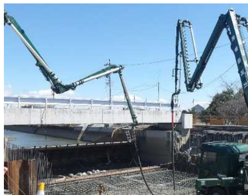
取水堰の施工状況（稲沢市）
