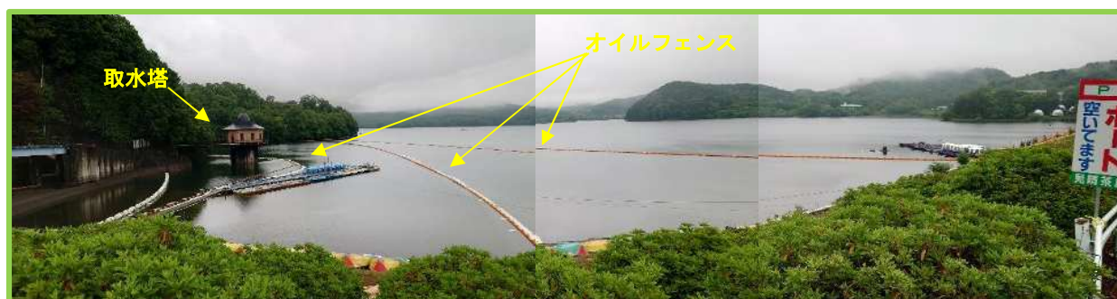
農業用水や河川への油の混入を防止するため3重に設置したオイルフェンス（池堤体から撮影）
