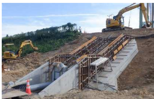
春日井奥池取水施設の施工状況（春日井市）
