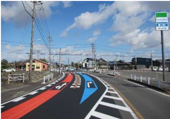
(事故危険箇所のカラー舗装対策) 写真：一宮津島線 大牧交差点
