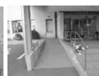
出入口の段差解消 事業費：30万円程度
