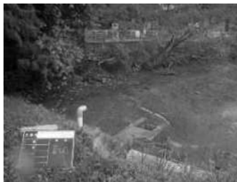
ため池堤体整備：施工前
