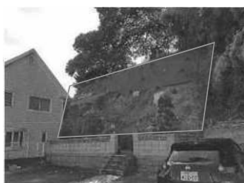
急傾斜地法面对策：施工前
