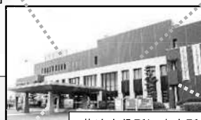
菊池市役所泗水支所
