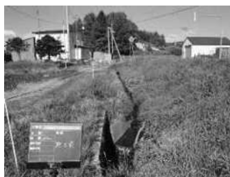
水路整備：施工前
