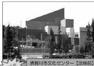
須賀川市文化センター【改修前】
