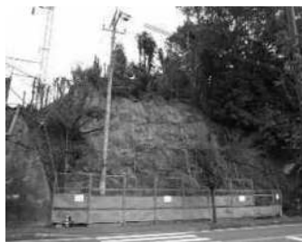
法面防護：施工前
