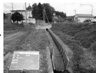
水路整備：施工後
