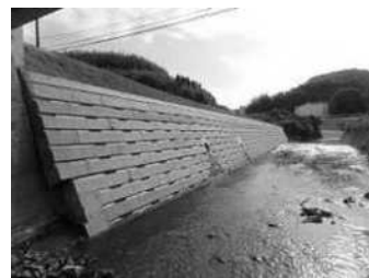
護岸整備：施工後
