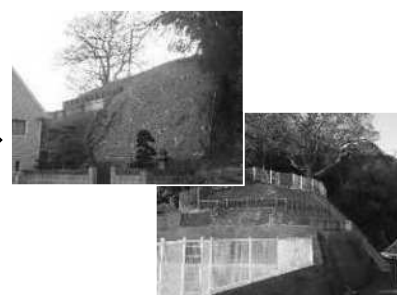
急傾斜地法面对策：施工後
