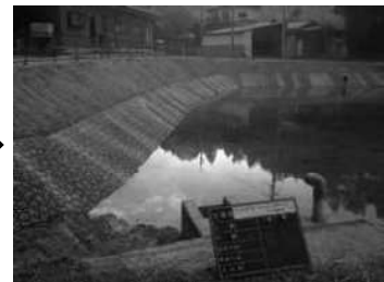
ため池堤体整備：施工後
