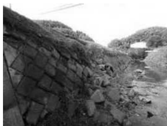
護岸整備：施工前
