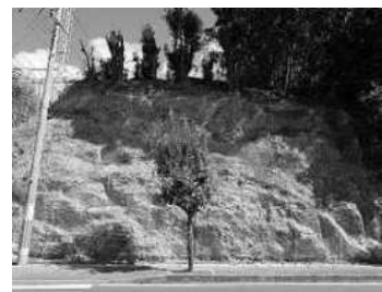
法面防護：施工後
