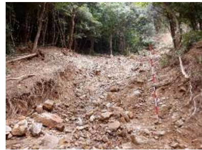
山地の崩壊状況
