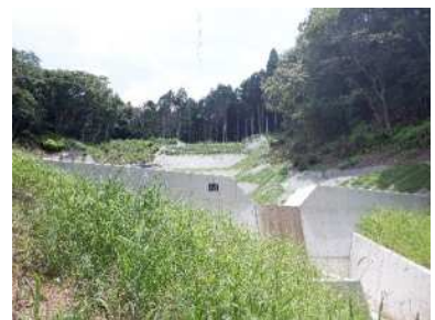
治山ダム工、土留工、山腹緑化工
