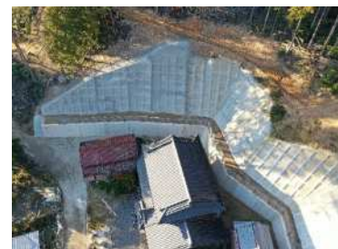
土留工、簡易法枠工
