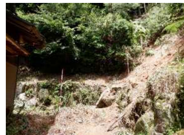
人家裏斜面の崩壊状況
