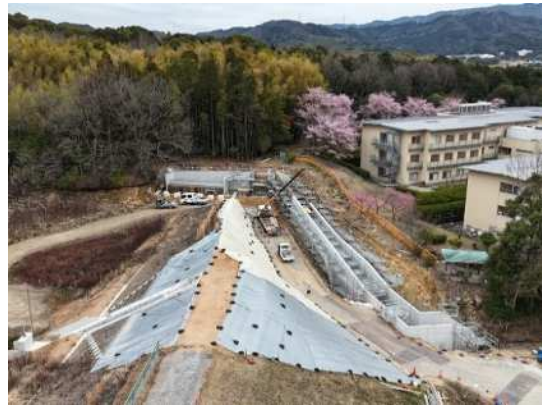
洞ヶ入池の洪水対策施工状況(幸田町)
