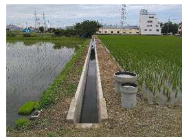
改修後の排水路（用水はパイプライン化）
