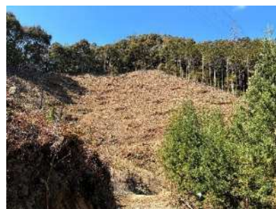
伐採・植栽現場
