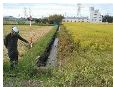
改修前の排水路
