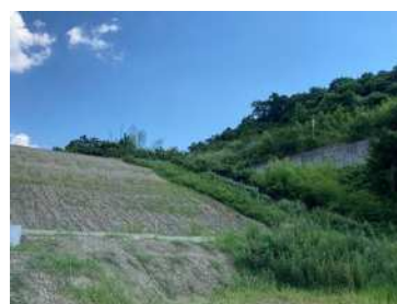
稲基池（洪水吐改修前）
