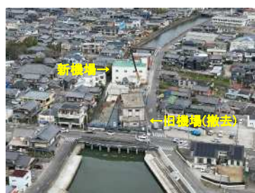
建設中の前野排水機場
