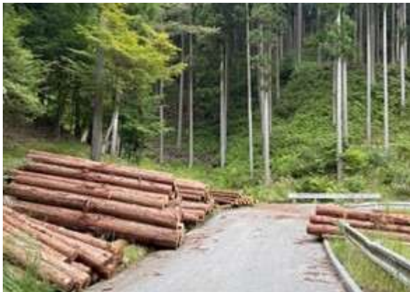
過疎山村地域代行林道事業（開設） 中口尤線2工区工事（設楽町）
