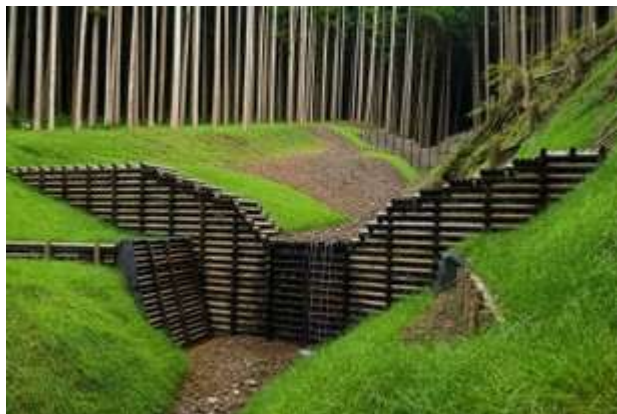
木製谷止工（設楽町）
