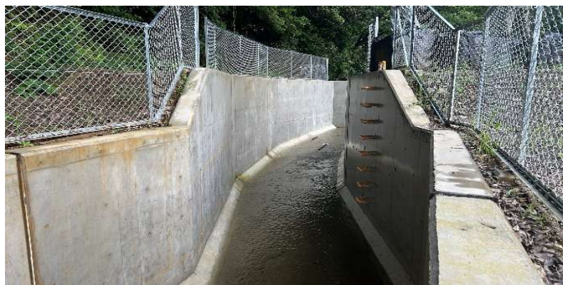
豪雨対策（洪水吐き）の整備（新城市黒田上の池地区）
