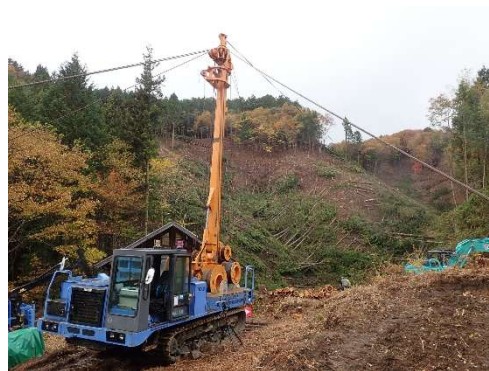
タワーヤーダによる集材（豊根村）
