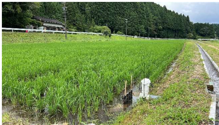
整備された用水路及び自動給水栓 (新城市作手菅沼地区)
