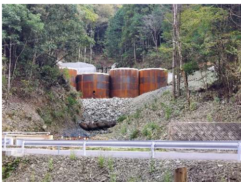
県道上部に完成した鋼製セル谷止工
