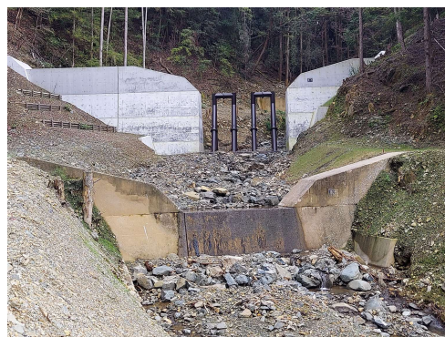
既設谷止工の上流に完成した鋼製スリット谷止工
