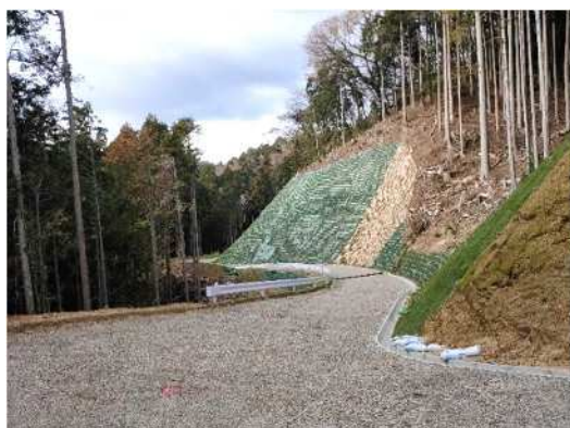
県営事業による林道開設
