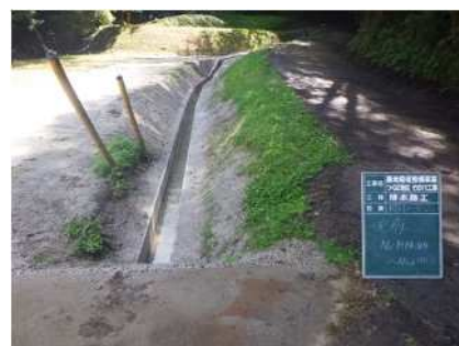
整備された排水路（つくば地区）
