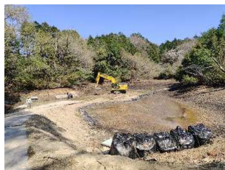
耐震化工事仮設進入路の施工状況 (防災ダム事業 徳間地区 池の内側)
