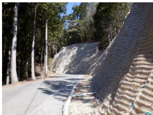
補助事業の改良による法面保護
