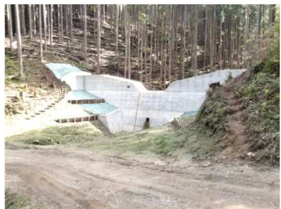
荒廃溪流に設置した治山ダム
