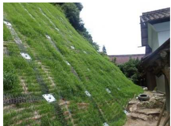
人家近接の山腹崩壊地に施工した補強土工
