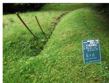
工事前の排水路（つくば地区）
