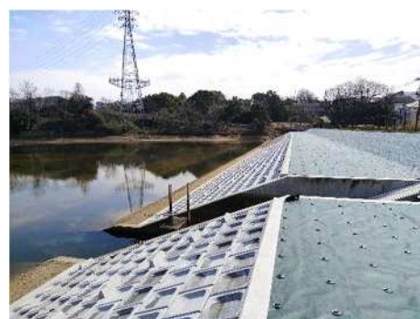
耐震化工事を終えた多羅釜池 (防災ダム事業 明知地区 池の内側)
