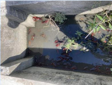
落水後の排水路の状況
