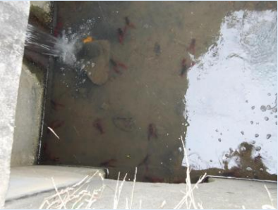
落水後の集水樹の状況
