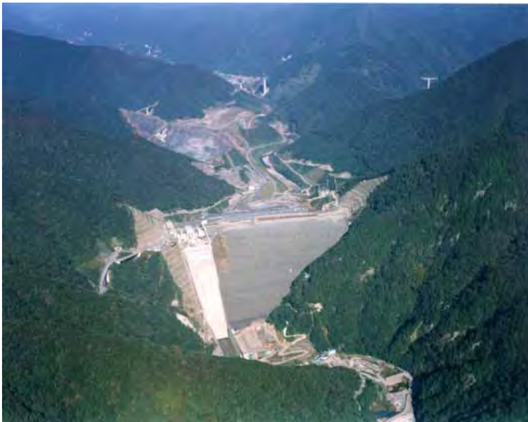
図 - 7 徳山ダム (建設中)
