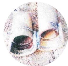
撤去したカラー継手部
