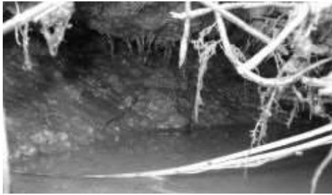
図5 エリアBのヨシ下の空洞
