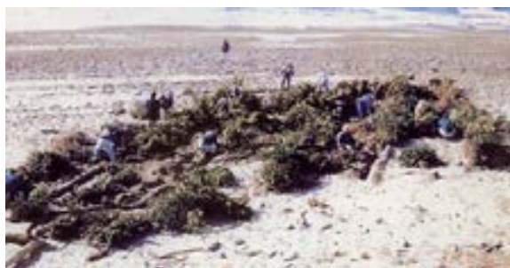
堆砂垣による砂浜の維持活動（御前崎市）
