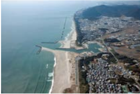
① 赤羽根漁港の周辺及び背後の状況 (田原市赤羽根町・池尻町)
