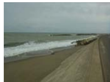
浜松五島海岸の侵食状況(H25.4)
