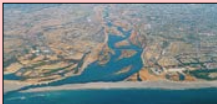
遠州灘に土砂を供給する天竜川
