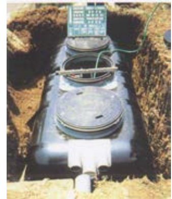
合併処理浄化槽
