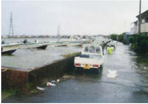
平成21年 台風18号時の二級河川 柳生川での高潮遡上状況（豊橋市）
