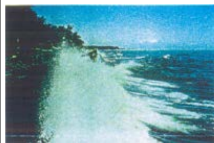
越波状況（三重県伊勢市）
