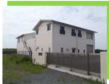
【集落排水事業による処理場整備】
