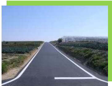
【経営体育成基盤整備事業による農道整備】
