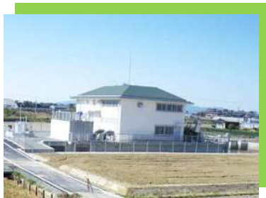
【排水機場の整備】
