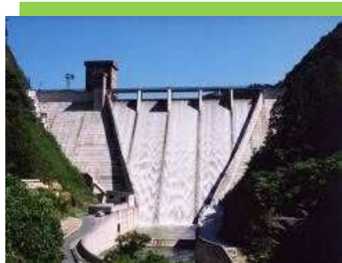
【豊川用水のみずがめの一つ「大島ダム」】
