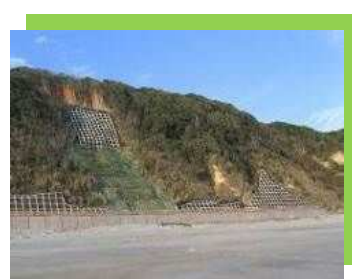
【保安林を保全する治山施設】
