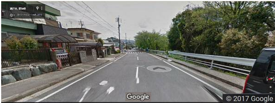
市道八幡台1号線 (八幡台外周道路)
