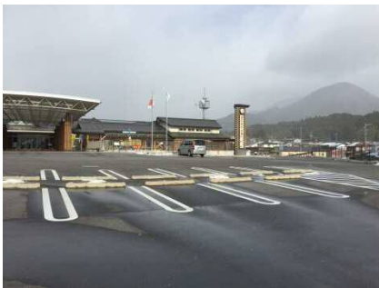
起点 設楽町役場
