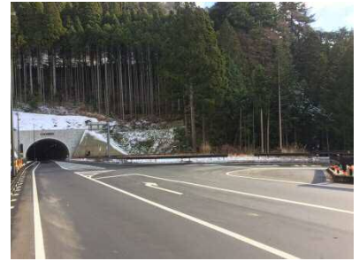
国道 473 号線から県道入口
