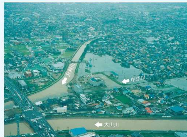
平成12年東海豪雨による浸水状況(合瀬川—中江川合流部)
