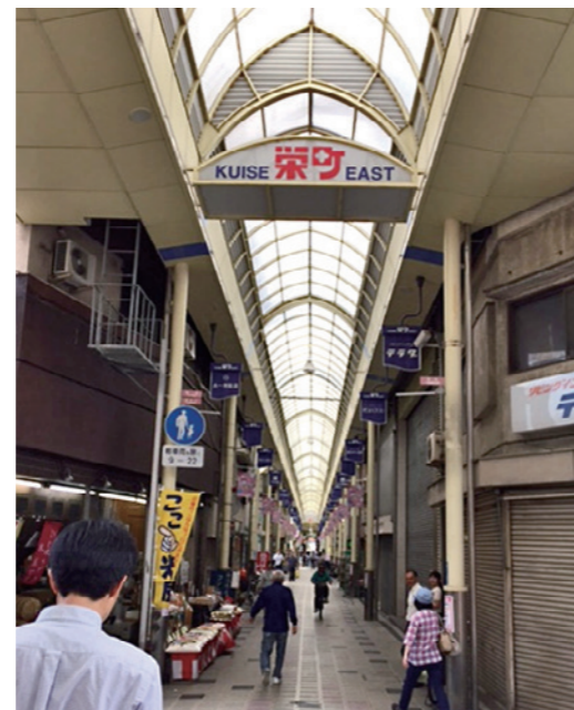
杭瀬栄町EAST商店街の様子
