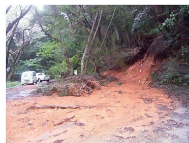
山腹斜面崩落
