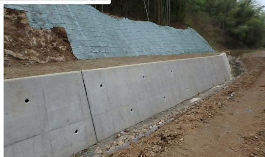
治山施設の整備後
