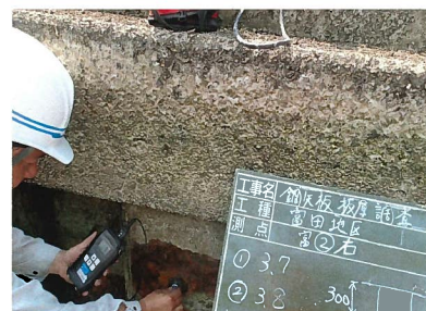
超音波厚さ測定（富永排水路）
