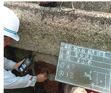
鋼矢板厚さ測定(富永排水路)
