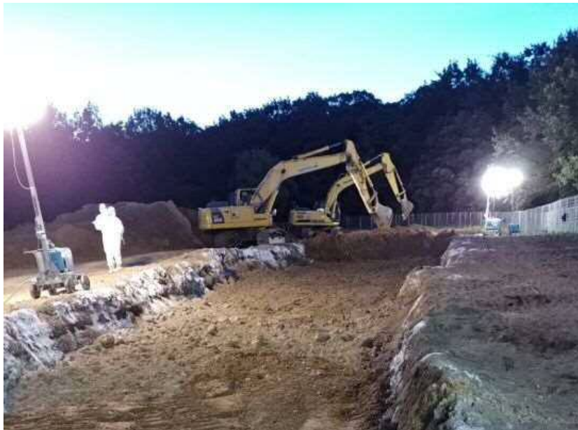
建設業者による埋却作業の様子
