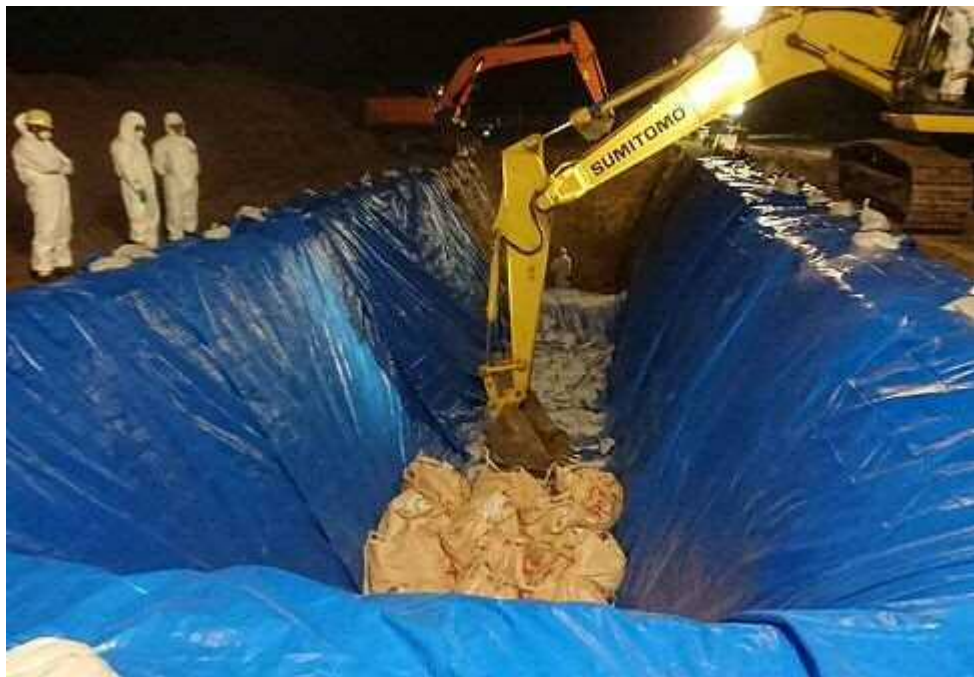
建設業者による埋却作業の様子
