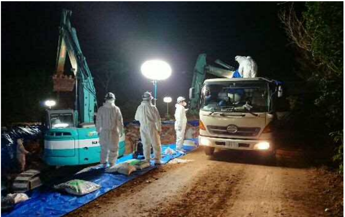
建設業者による埋却作業の様子
