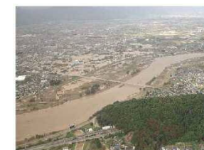
台風第 19 号による河川堤防の決壊
