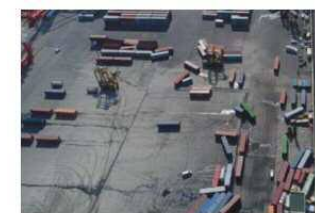
台風第21号（2018.7）によるコンテナの流出
