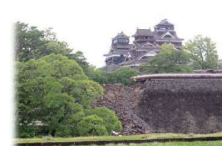
熊本地震による熊本城の被災
