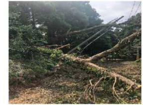
台風第15号における倒木による電柱倒壊
