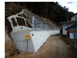
治山施設の整備
