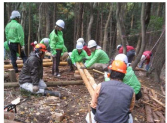
写真16 企業の社員による土留め作業
