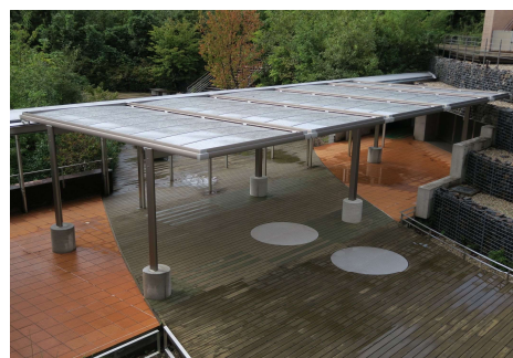
写真18 ウッドデッキ屋根工事(竣工)
