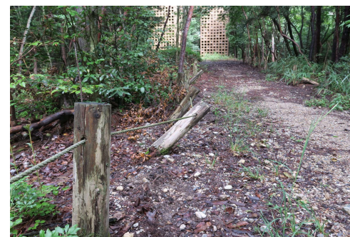
写真2 柵の腐朽
