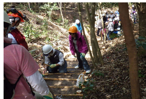
写真1 CKDによる丸太階段の補修
