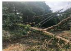
令和元年房総半島台風（台風第15号）における倒木による電柱倒壊
