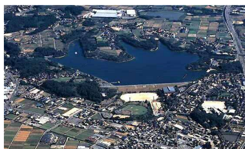
耐震対策を行う三好池(みよし市)
