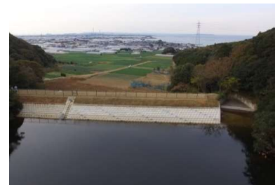
ため池の耐震対策
