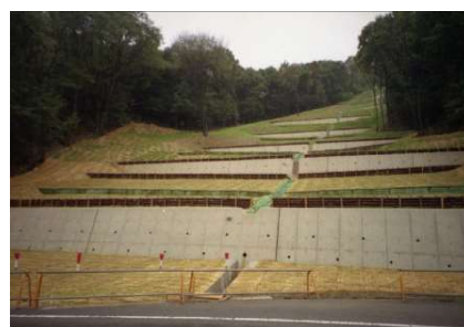
治山施設の整備
