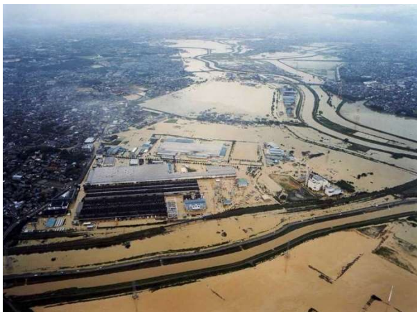
図 2000年の東海豪雨による被災状況
