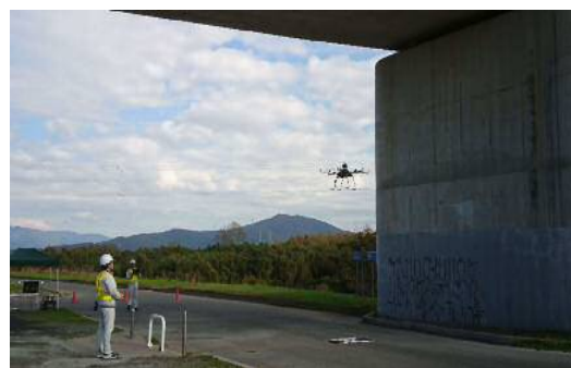
無人飛行ロボットによる橋梁点検の民間実証実験 ((主)東三河環状線(豊川市):三上橋)
