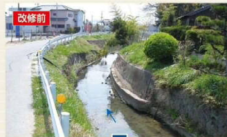
砂川/玉川橋下流付近
