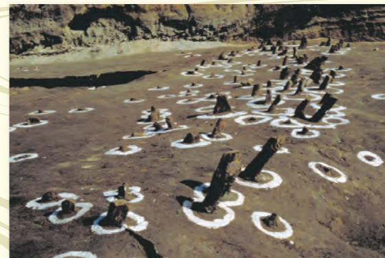
地面に杭を打ち込んだバリケード
