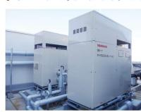
ガスエンジンにより発電し、その際発生する熱を捨てずに温水として空調システムの熱源として利用
