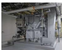
太陽熱とガスマイクロコージェネレーションの2種類の廃温水を1台で同時に回収可能
