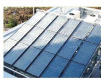
太陽熱集熱器により温められた温水を空調システムの热源として利用
