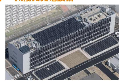
発電効率の高い単結晶型太陽光発電パネルを本施設の屋上と地上、南外壁面の一部に敷設。また、南外壁面の一部には、シースルー型太陽光発電パネルを採用しており、発電量を確保しつつ、眺望や採光、デザイン性にも配慮
