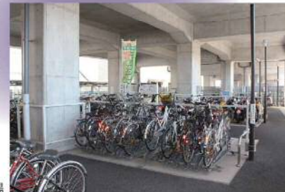
高架下を利用した駐輪場
