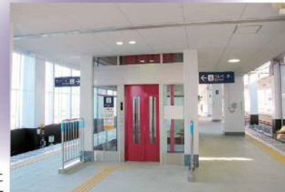
駅に設置されたエレベーター
