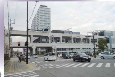
踏切が除却された道路
