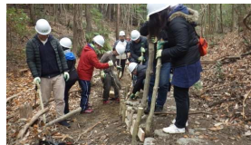
写真3 企業連携による歩道補修
