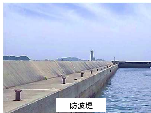
漁港施設の整備
